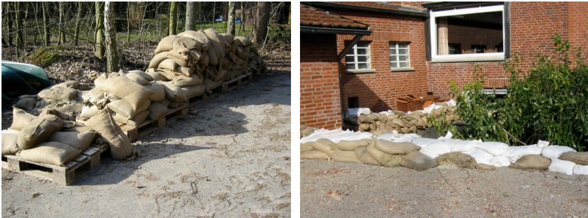
Abbildung 4.2: Objektschutz durch Sandsäcke in Münster-Angelmodde
